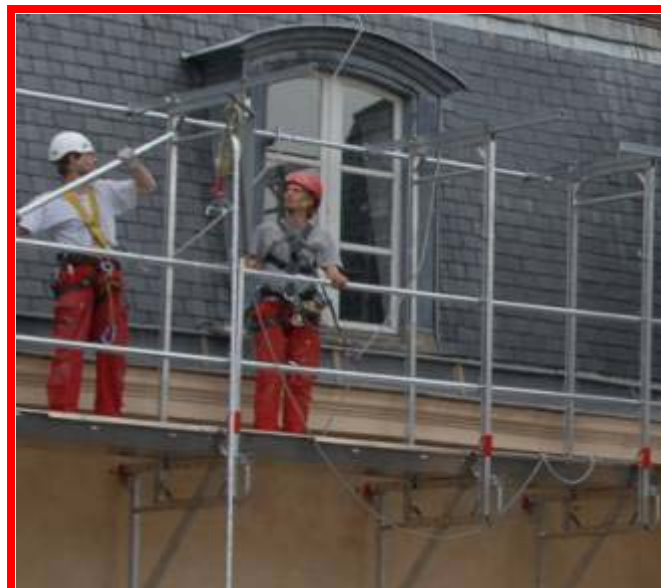
15 Poser les 3 lisses sur les cadres
