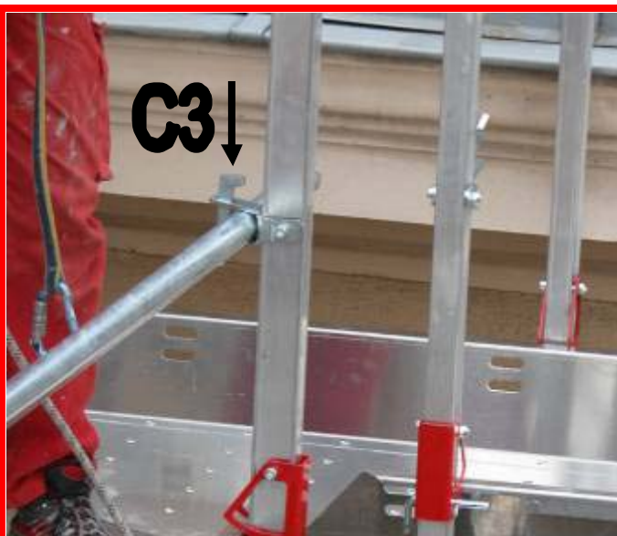
16 Claveter (C3) les lisses sur les cadres
