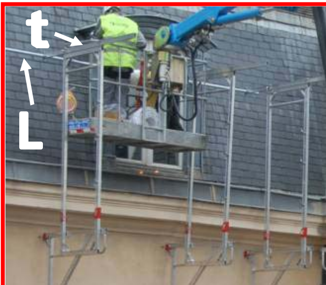
13 Relier toutes les traverses (t) par des lisses (L), reliées entre elles par des goupilles 020020 (g)
